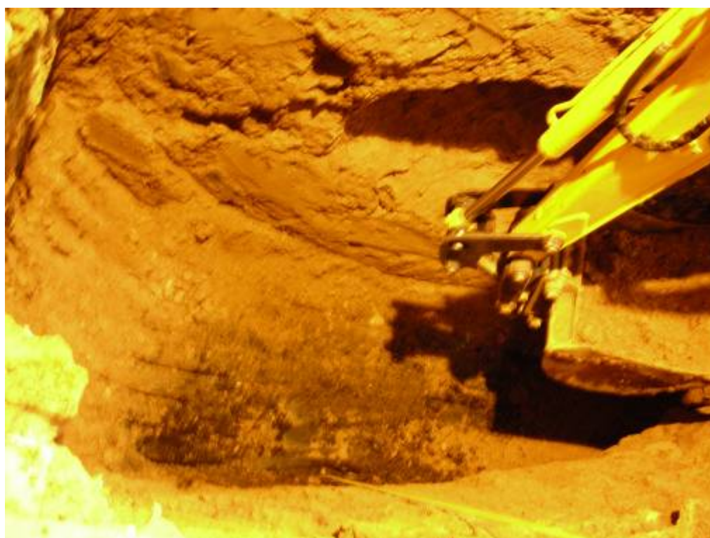
Fotografia 4. Visió del rebaix efectuat per la màquina als estrats de sorres U.E. 110 i UE 112.
